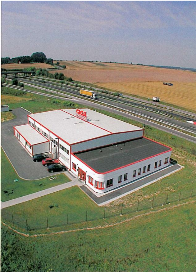
První etapa výstavby výrobní haly v Příšovicích
